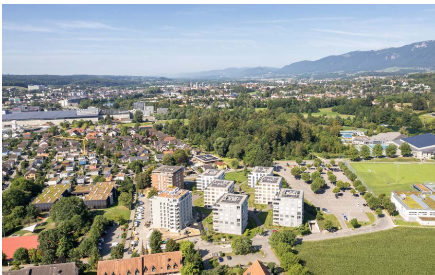
Luftaufnahme Erweiterung Volaare-Quartier, Zuchwil Amselweg 43 und Lerchenweg 26 mit 78 Wohnungen
