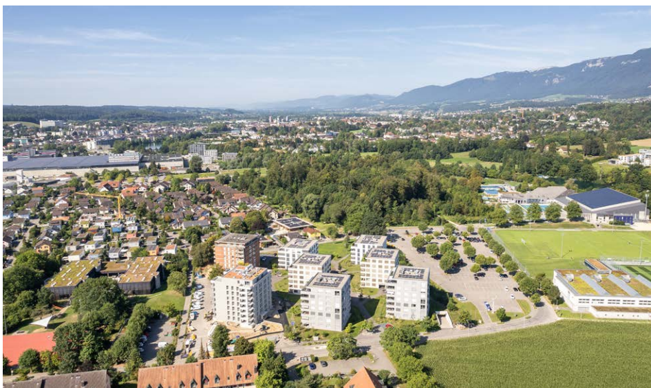
Luftaufnahme Erweiterung Volaare-Quartier, Zuchwil Amselweg 43 und Lerchenweg 26 mit 78 Wohnungen
