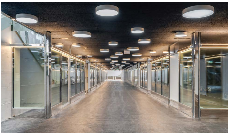
Untergeschossentwicklung am Bahnhof Solothurn Süd Sanierung Zuchwilerstrasse 41/43, Solothurn
