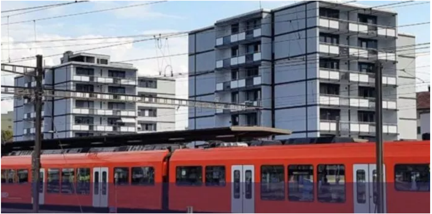
Die beiden Gebäude Zuchwilerstrasse 41/43 am Solothurner Bahnhof wurden von einem Schüler des legendären Architekten Fritz Haller erbaut. Nicht zufällig erinnern sie an das modulare Einrichtungssystem USM Haller. Unter anderem finden sich hier auch die Büros von Espace Real Estate. Bild: zVg.
