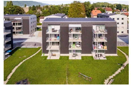
2017 wurde die erste Etappe mit 36 neuen Wohnungen der Überbauung «Les Amis» am Narzissenweg in Biel fertiggestellt. Bild: espacereal.ch
