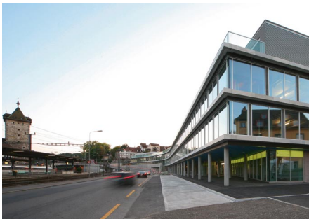
Nord-Ostfassade Landhaus Schaffhausen
