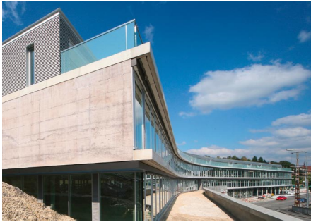
Süd- und Ostfassade Landhaus Schaffhausen
