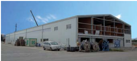
Gewerbehalle Industriestrasse, Subingen
