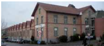
Ehemalige Weberei, Enggistestrasse 77, Worb b. Bern
