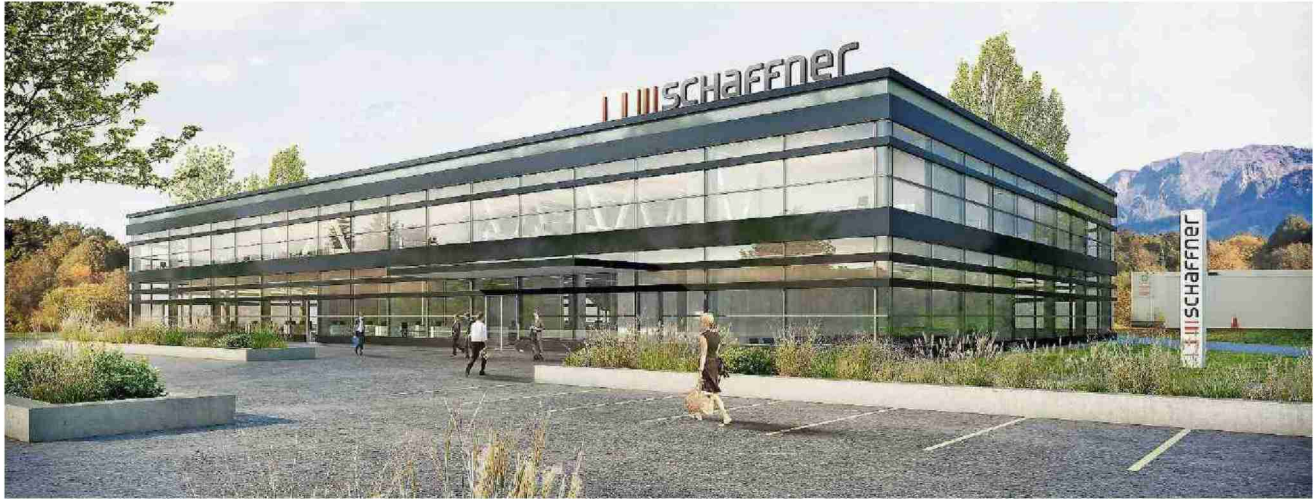
Ab Ende 2017 wird das Headquarter der Schaffner AG in diesem Neubau am bisherigen Standort in Luterbach angesiedelt sein.
